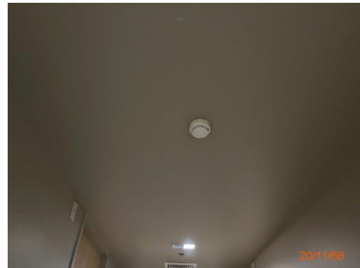
รูปที่ 2-22 อุปกรณ์ตรวจจับควัน
