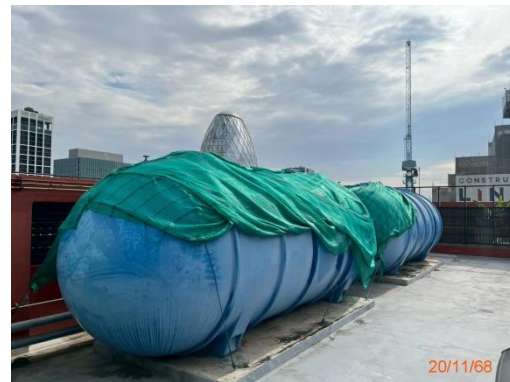
รูปที่ 2-34 ถังเก็บน้ำใช้และน้ำดับเพลิงชั้นดาดฟ้า
