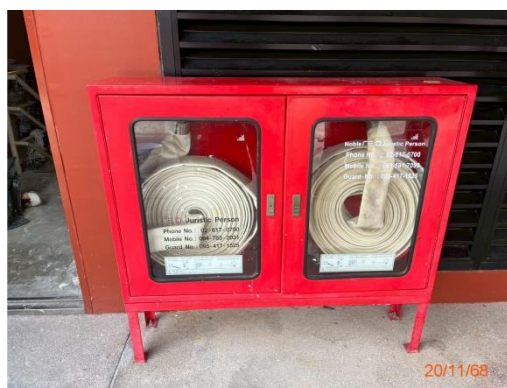
รูปที่ 2-29 ตู้เก็บสายน้ำดับเพลิงชั้นตาดฟ้า
